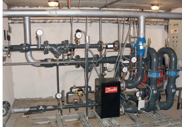
Рис. 1. Типовое жилое здание в районе Жулебино (г. Москва) и установленный в нем БТП Danfoss.
